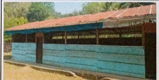
Foto 6: Mejoramiento de aulas con cambio de laminas
