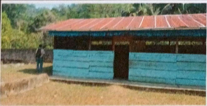
Foto 5: Complementación de paredes de aulas
