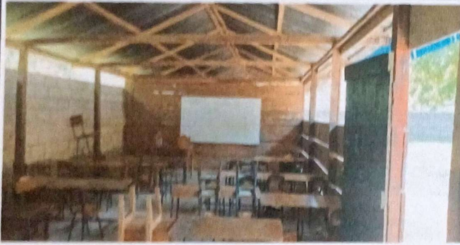
Foto 3: Cambio de vigas y costaneras
